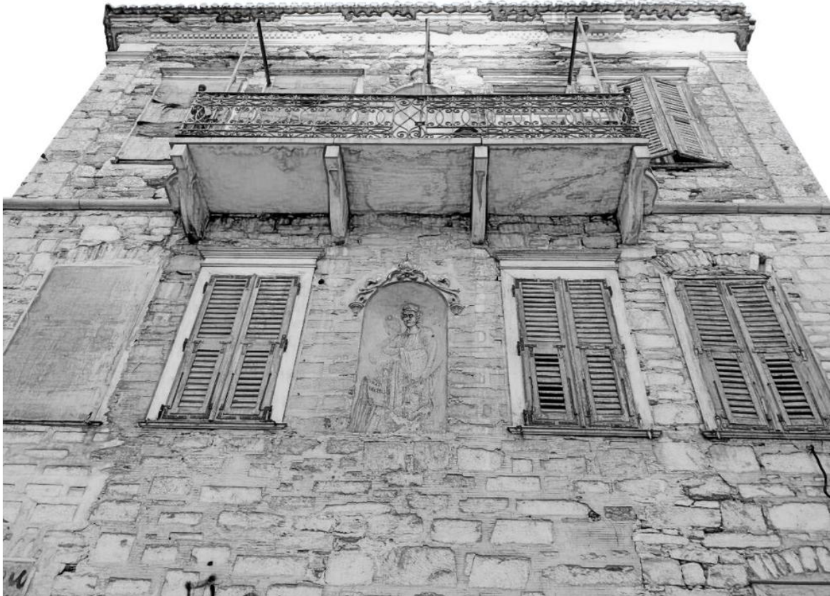
Εικόνα 16. Η πέτρινη τοιχοποιία της δυτικής όψης, δείγμα από τα γερμανικού τύπου παραθυρόφύλλα, το μπαλκόνι με τα μαρμάρινα φουρούσια από κάτω και το περίτεχο κιγκλίδωμα
